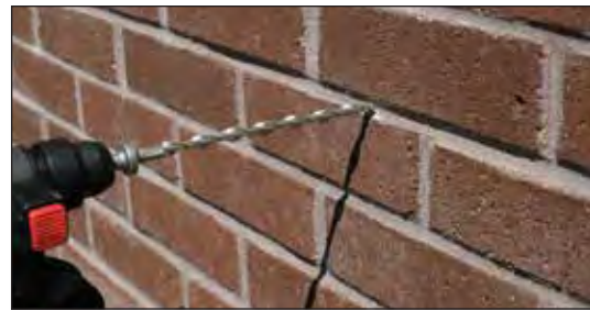
Heli-Tie™ Helical Wall Tie
